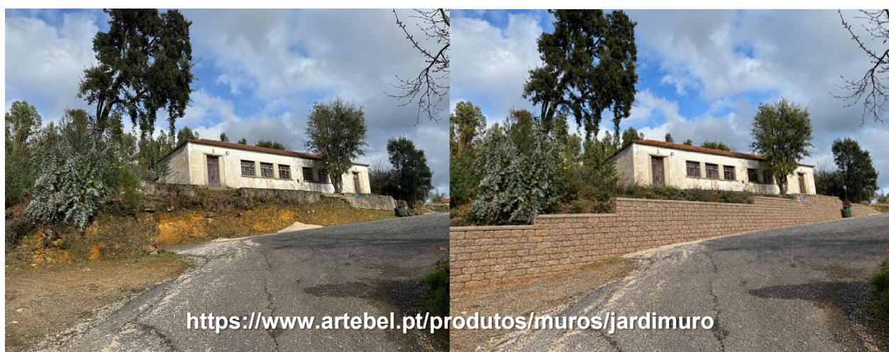
Simulação de construção de muro de suporte com materiais pré-fabricados para segurar as terras e proteger o edifício.
